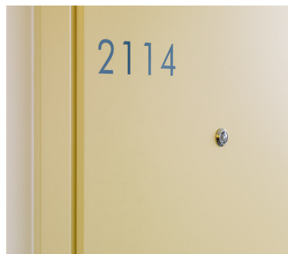
Den moderna Daloc-dörrens karakteristiska snedfasade överfals ger dörren ett snyggt utseende
